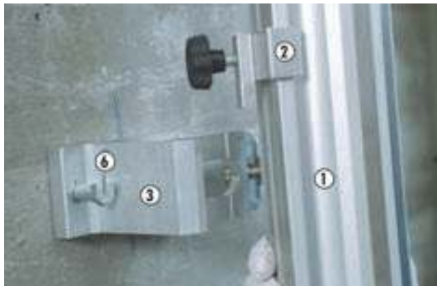
Montaje de los soportes del carril con soportes estándares
