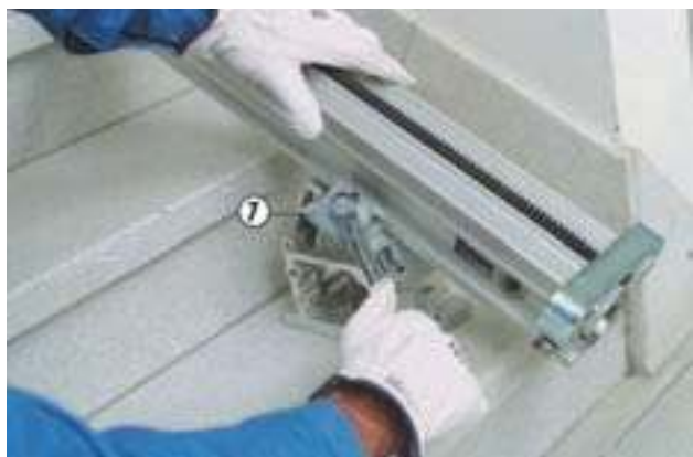
Montaje de los soportes del carril con soportes para corte escalonado y en diagonal
